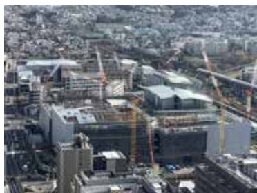
新キャンパス工事現場 全体俯瞰(京都タワーから)
